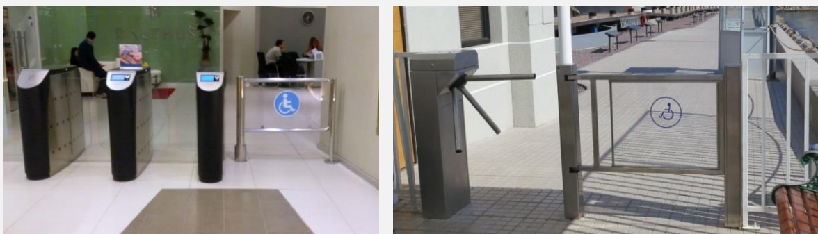
Foto 66 y 67: Control de acceso alternativo accesible a la entrada general por torniquetes.
