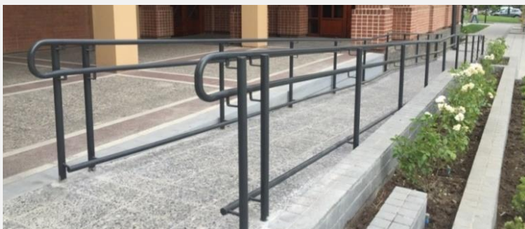
Foto 51: Rampa con pasamanos a doble altura. Ambos pasamanos deben ser continuos, de manera que el deslizamiento de la mano no se interrumpa en todo el trayecto.
