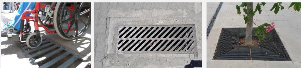
Foto 16 (izq): Rejillas dispuestas peligrosamente a favor de la circulación peatonal pudiendo causar atascos de las ruedas.
