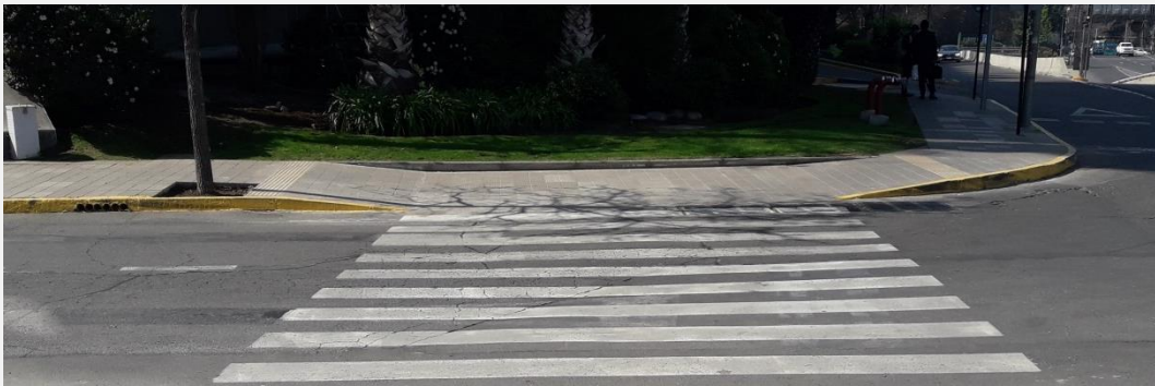
Foto 10: Cruce peatonal rebajado en todo su ancho hasta igualar la altura con la calzada
