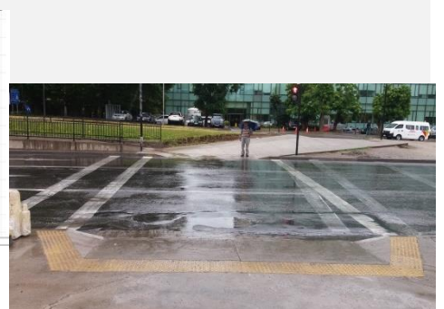
Foto 5: Rebaje en cruce peatonal de 3 pendientes o alas laterales.
