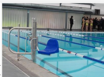
Fig 99: Espacio de aproximación que debe existir a un costado del elevador hidráulico para piscinas. Foto 83: Elevador hidráulico en una piscina municipal.
