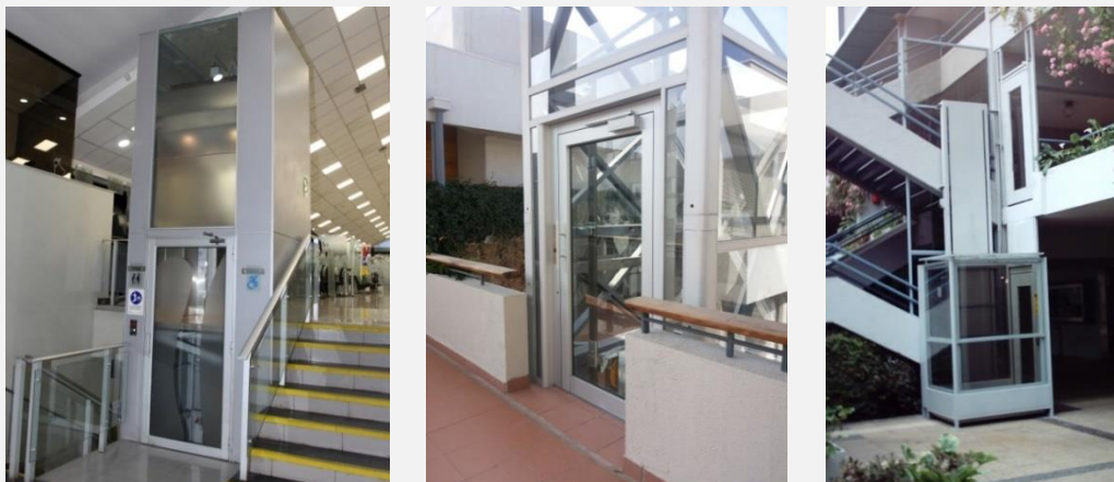
Foto 59, 60 y 61: Elevadores que parecen corresponder a los tipos de "especiales para personas con discapacidad", para ser instalados únicamente en locales escolares, viviendas o edificios existentes destinados a servicios. Ver definición "Ascensor especial"***
