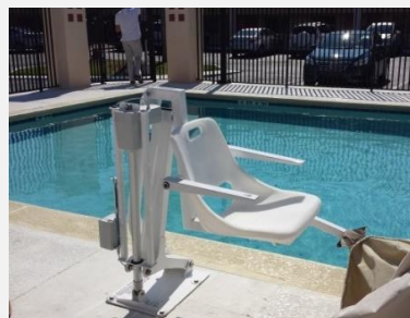
Fig 102: Los hoteles con piscinas deben contar con algún dispositivo para acceder a ésta. Foto 91: Elevador hidráulico en piscina de hotel. Foto 92: Camarín con cubículo de baño accesible.
