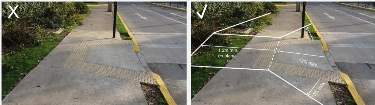
Foto 11 y 12: Ejemplo de cruce peatonal de 3 pendientes al cual se debe añadir espacio de la acera para sumar los 1,2m adicionales en plano que se requieren después del cruce.
