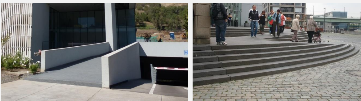
Foto 53 (izq): Los planos inclinados de pendiente igual o inferior a 5% están exentos de los requisitos de rampa. Foto 54 (der): Las rampas combinadas con escaleras deben responder a planos inclinados con pendientes igual o menor a 5% para evitar la obligación de pasamanos.
