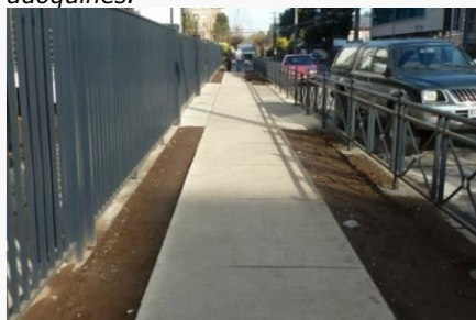
Foto 2: Vereda sin obstáculos y de pavimento estable, que conforma una ruta accesible en todo su ancho.
