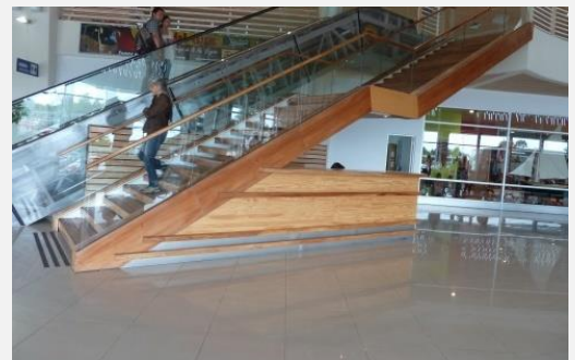
Foto 49: Protección bajo el área de escalera donde podría ingresar una persona ciega.
