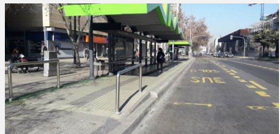
Foto 23: Paradero conectado a vereda mediante rampa.
