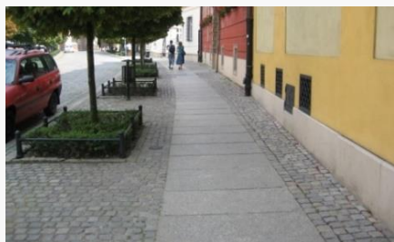
Foto 1: Ruta accesible en vereda, diferenciada en pavimento estable del resto de la acera de adoquines.
