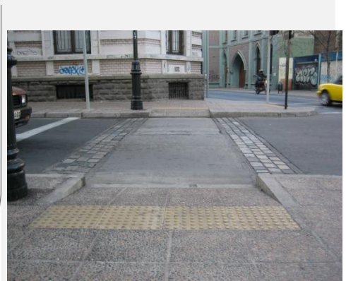
Foto 4: Rebaje en cruce peatonal de una pendiente con textura de alerta antecediendo la rampa.
