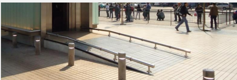
Foto 52: Rampa con protección lateral.
