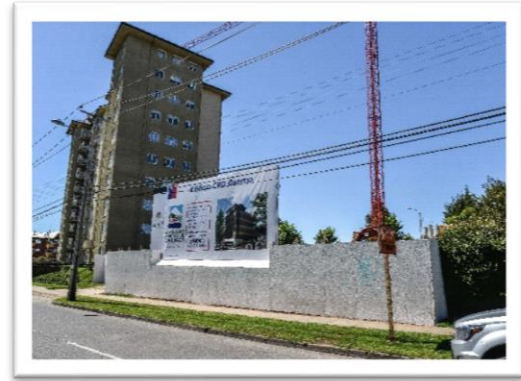
Entrega terreno para construcción CRD
